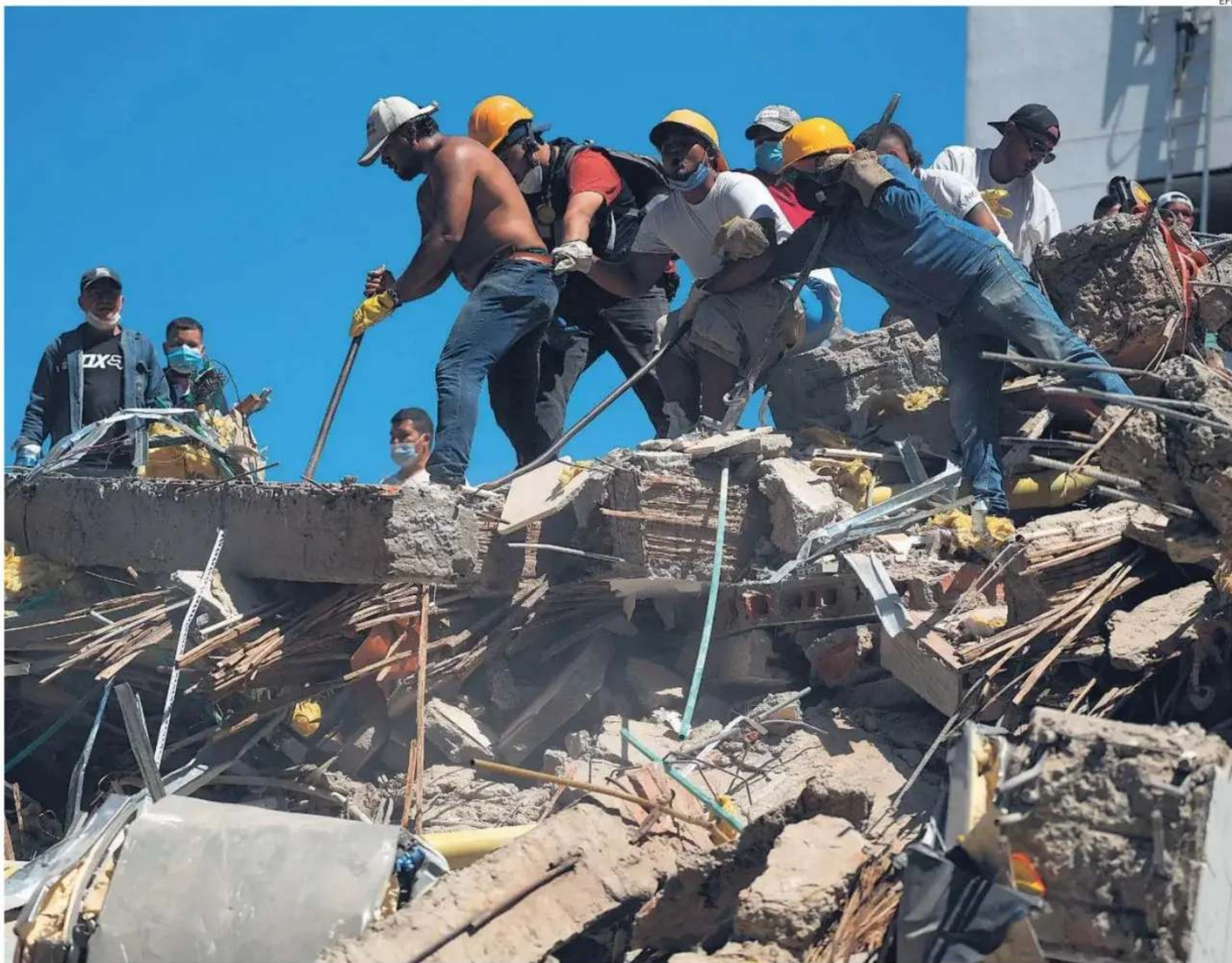
Personas trabajan en labores de rescate en una edificación colapsada por el terremoto
